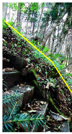
図3. 石段南側(下から見て右手)方向の斜面傾斜の変換部。
