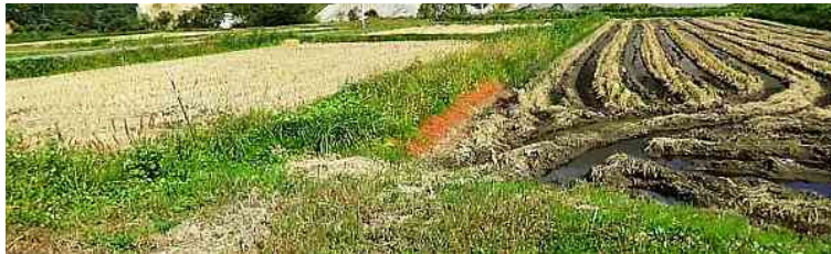
図 5: 城山の東側の水田。稲刈り後だが、左の水田と比べて、地震により撓曲した右側の水田の水はけが極端に悪い。
