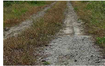
図 6: 図 5 の水田の東側のあぜ道。写真中央部を左右に撓曲が横切り、道が粘土状に固まっている。
