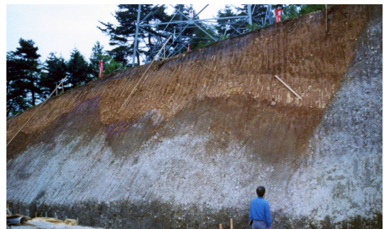
図3. B 地点で見られた On-Pm1 を切る正断層群。
